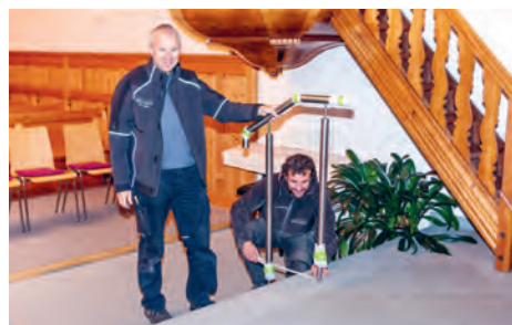
Fredi Niederer und Mitarbeiter bei der Montage
