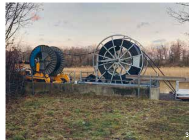
1. Verlegung mehrerer Kabelschutzrohre TS ARA bis TS Rhein 2. Tiefbau Netzverstärkung Idyll 3. Bobinen für Kabelzug bei TS Rhein
