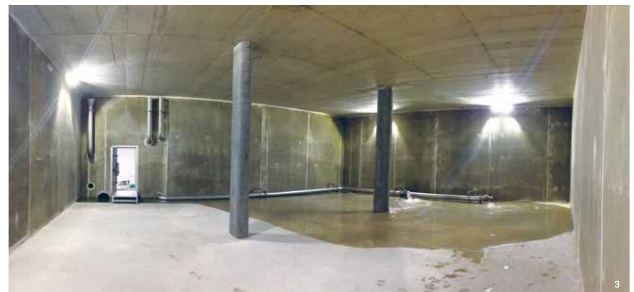
1. Einzug Wasserleitung durch Bohrloch bei N1 2. Neubau Reservoir Steiniger Tisch 3. Reservoirkammer Steiniger Tisch
